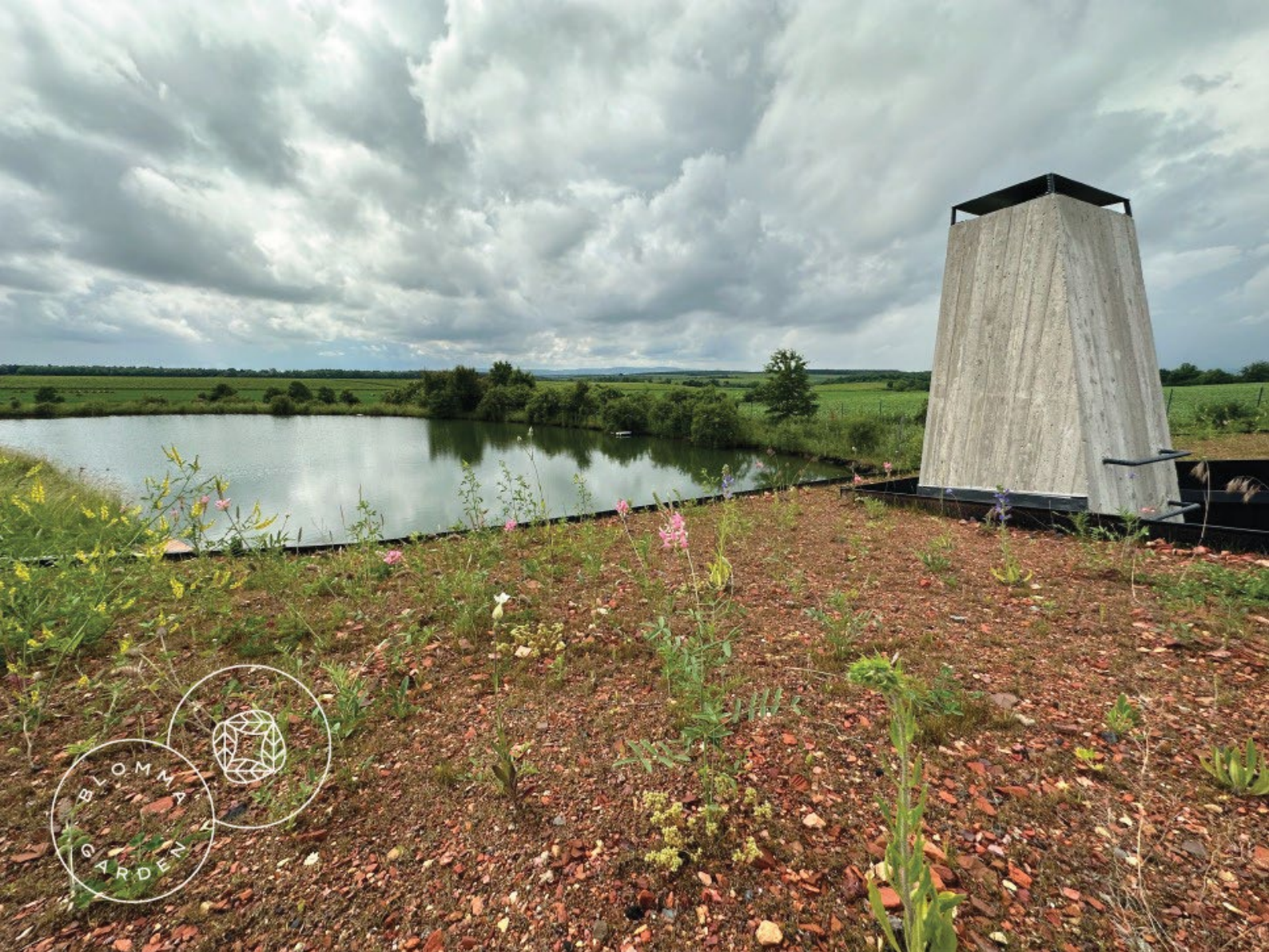
2023 ETYEK, ZÖLDTETŐ + PARKÉPÍTÉS
